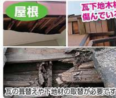
瓦の差し替えと下地防水材取替が必要です
