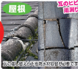
瓦の葺き替えや下地材の取替が必要です
