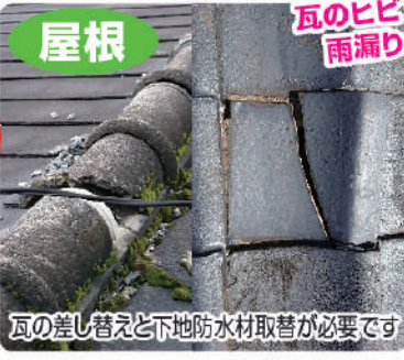
瓦の葺替えや下地材の取替が必要です
