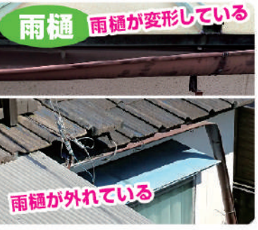
瓦の葺替えや下地材の取替が必要です
