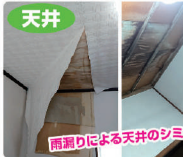
瓦の葺替えや下地材の取替が必要です
