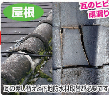
瓦の葺替えや下地材の取替が必要です
